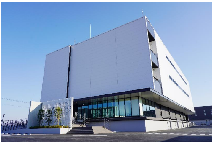
両毛システムズデータセンターの外観
